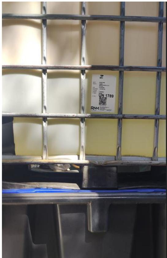
Figura 7 – Bacia de contenção na ETA da Endutex – Tinturaria e Acabamento de Malhas S.A.
