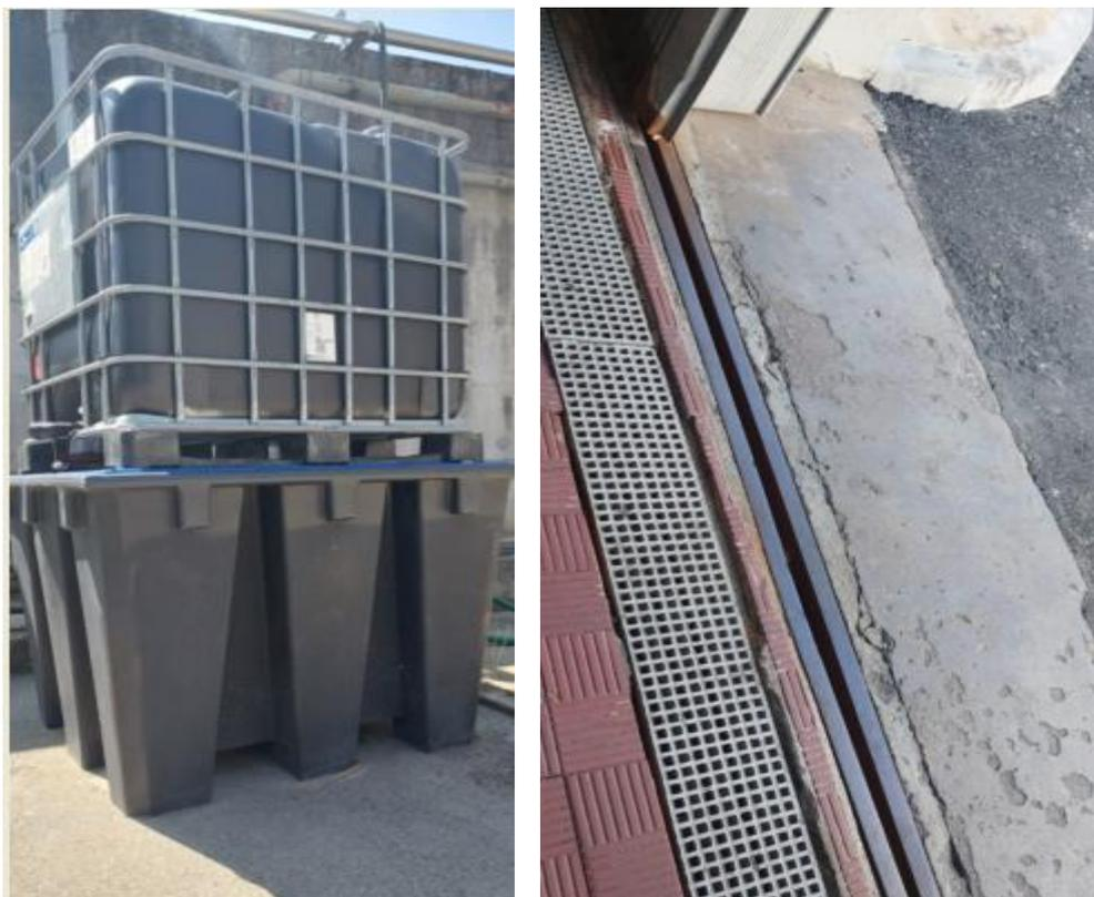
Figura 5 – Bacia de contenção e grelhas de ligação na Endutex – Tinturaria e Acabamento de Malhas S.A.
