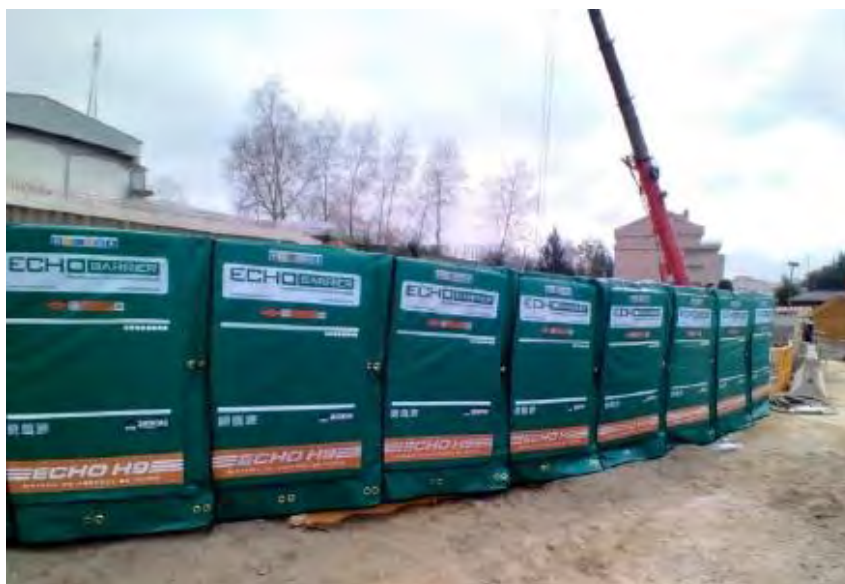
Figura 25: Exemplo de barreira acústica fixa desenhada especificamente para resistir às condições de obra
