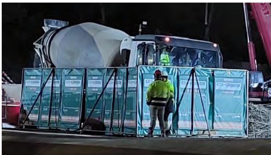
Figura 26: Exemplo de barreira acústica amovível desenhada especificamente para resistir às condições de obra e ser facilmente movida
