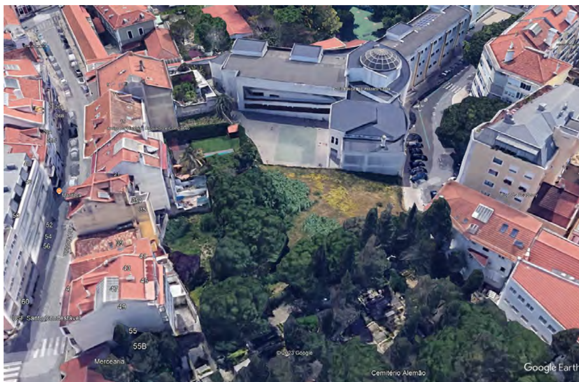
Figura 10: Imagem 3D (Google Earth) da Escola Ressano de Garcia, vista de nordeste para sudoeste
