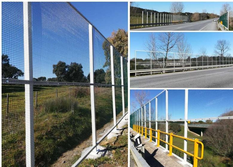
FIGURA 4 – EXEMPLO DE BARREIRAS DE PROTEÇÃO, COM 3 M DE ALTURA (A PARTIR DA PLATAFORMA), CONSTITUÍDAS POR PRUMOS METÁLICOS DE SECÇÃO RETANGULAR RHS 80x60x3, COM TAMPAS PLÁSTICAS NO TOPO, AFASTADOS DE 2 M, QUE PERMITEM SUPORTAR UMA MALHA DE ARAME GALVANIZADO, SOLDADA E PLASTIFICADA A PVC/POLIÉSTER, COM DIÂMETRO DE 19 X 19 MM E DIÂMETRO DO ARAME DE 2 MM. OS PRUMOS SÃO ENCASTRADOS NO MACIÇO DE FUNDAÇÃO (IP, 2021).
