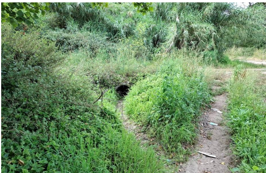
Foto 4-2 – Drenagem transversal a montante do PCCB
