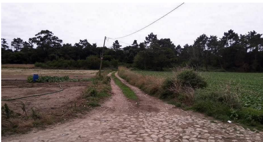
Foto 4-22 – Vista a partir da Rua da Painça para a zona norte do PCCB
