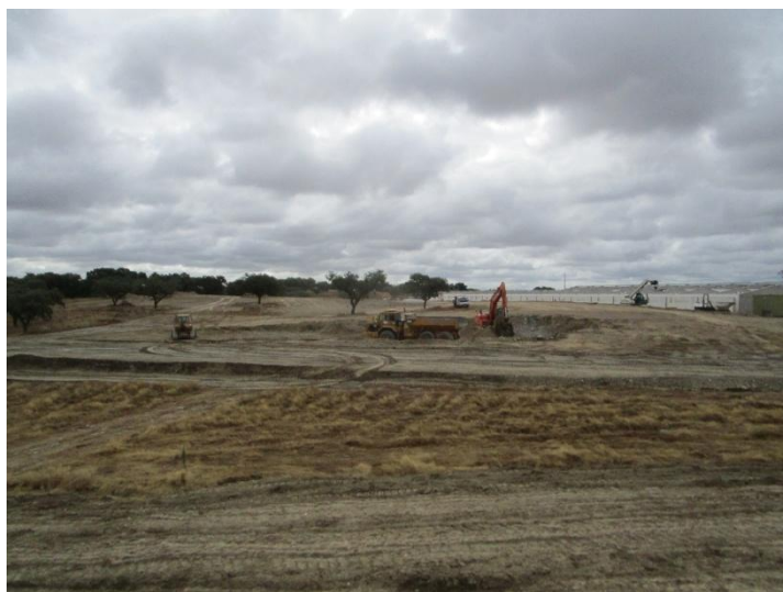
Figura 67 – Vista geral do terreno (solo artificializado) com a construção dos pavilhões em curso (1ª fase)
