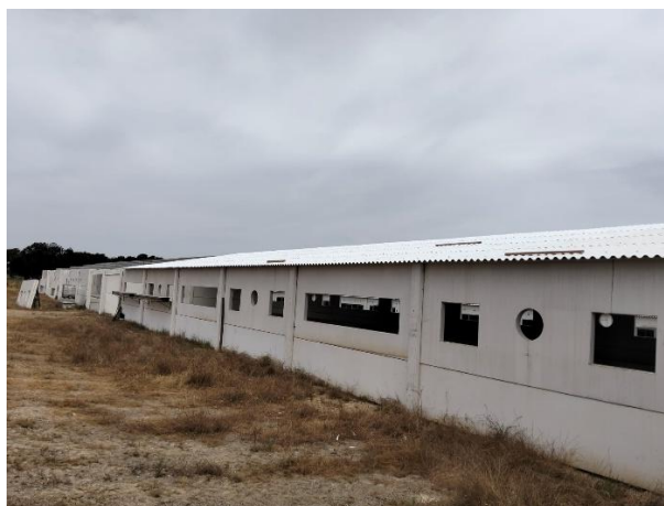
Figura 3 – Pavilhões 4 e 5 em construção
