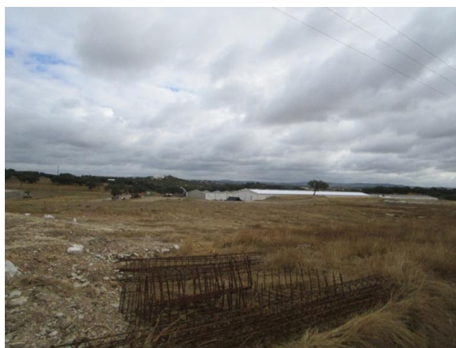
Figura 66 – Vista geral do terreno (visibilidade média) com a construção dos pavilhões em curso (1ª fase)
