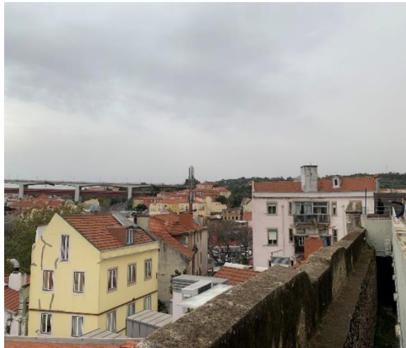
Fotografia 2.11 – Vista da muralha do Baluarte do Livramento para a guarita e edifício a demolir/reconstruir.
