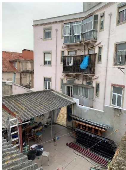
Fotografia 2.16 - Vista para o edifício intersetado e edificações adjacentes a demolir.
