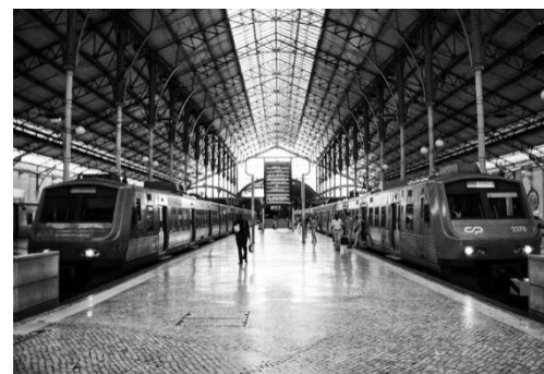
Fotografia 3.8 – Estação Ferroviária do Rossio, Lisboa (1890)
