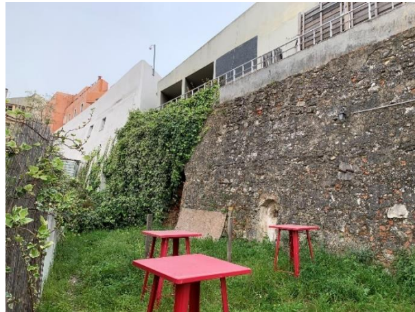
Fotografia 2.14 - Vista para a muralha do Baluarte.
