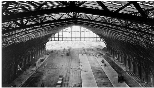
Fotografia 3.1 – St. Pancras Station, Londres (1868)
