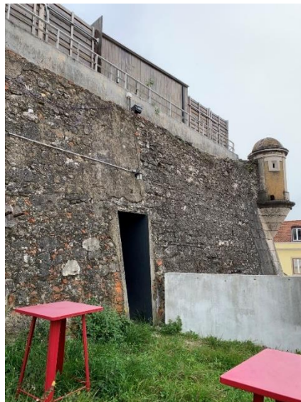
Fotografia 2.15 - Vista para a muralha e guarita do Baluarte.
