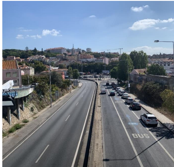
Fotografia 2.5 – Vista do Acesso à Ponte 25 de Abril para o local de intervenção.
