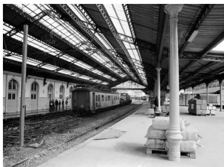
Fotografia 3.7 – Estação Ferroviária de Alcântara-Terra, Lisboa (1887)
