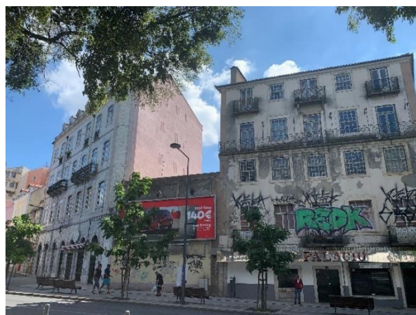
Fotografia 2.7 – Edifício a demolir e reconstruir e a sua envolvente
