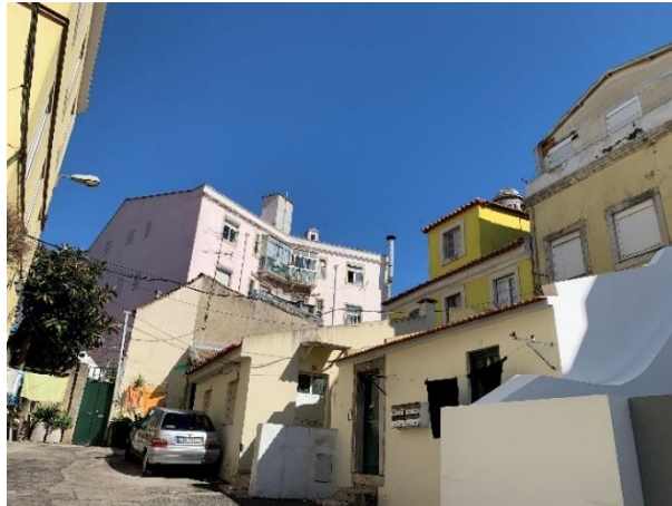
Fotografia 2.8 – Vista para o edifício intersetado e edificações adjacentes a demolir.
