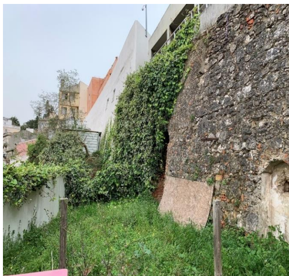
Fotografia 2.13 – Vista para a muralha do Baluarte.
