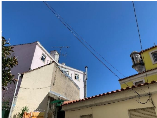
Fotografia 2.9 – Relação entre o edifício intersetado e o Baluarte.
