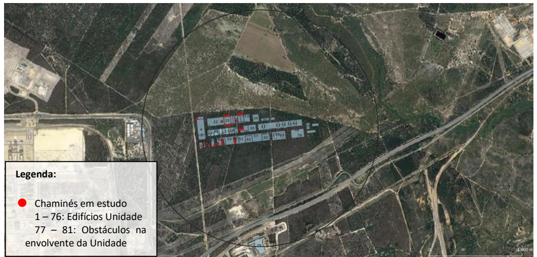
Figura 2.1 – Apresentação dos obstáculos inseridos no raio de 300 metros, a partir das fontes em estudo, incluindo os edifícios da própria instalação (Imagem do ano 2023 do Google Earth )
