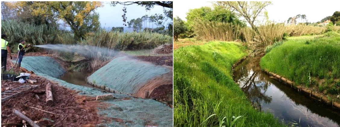
Figura 15 – Aplicação de hidrossementeira sobre manta orgânica [Gançaria, Santarém, 2018] |
