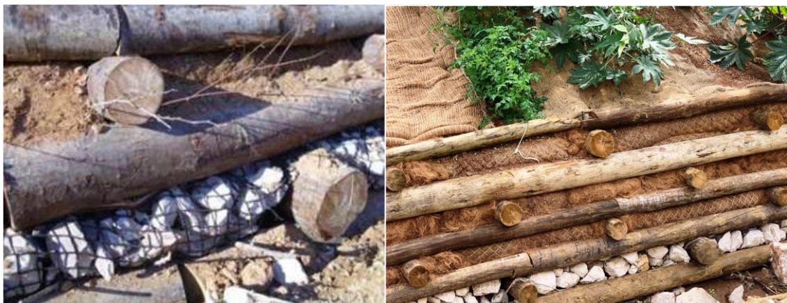
Figura 11 – Aplicação de gabiões cilíndricos e bio rolos de coco como reforço dos interstícios frontais do Cribwall. | Fonte: EcoSalix
