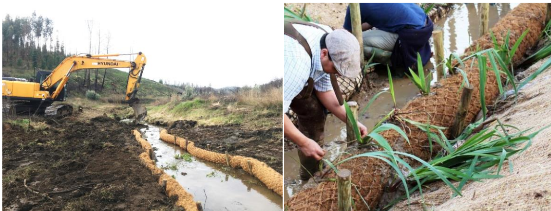
Figura 13 – Aplicação de bio rolo de coco em estabilização de emergência pós-fogo (esq.: Proença-a-Nova, 2019), e instalação de vegetação aquática em bio rolo de coco (dir.: Arneiro das Milhariças, 2017) | Fonte: EcoSalix
