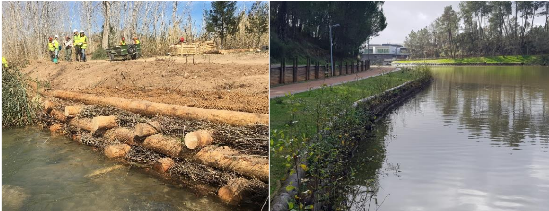
Figura 10 – Construção de Cribwall para consolidação de rombo fluvial (Pedralba, Espanha, 2019) e para proteção de percurso no Parque do Bonito (Entroncamento, 2021). | Fonte: EcoSalix
