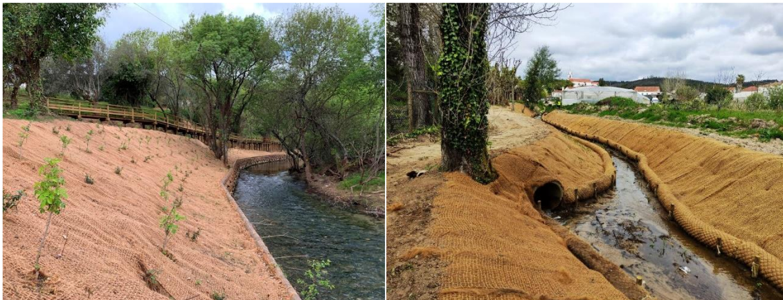
Figura 14 – Aplicação de manta orgânica sobre Cribwall (Olhos d’Água, Alcanena, 2021) e em margem fluvial (Olival, Ourém, 2022) | Fonte: EcoSalix
