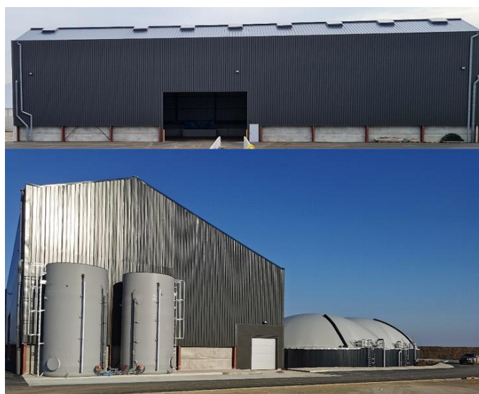
Fotografia 4.4 – Exemplo de edifício de exploração
