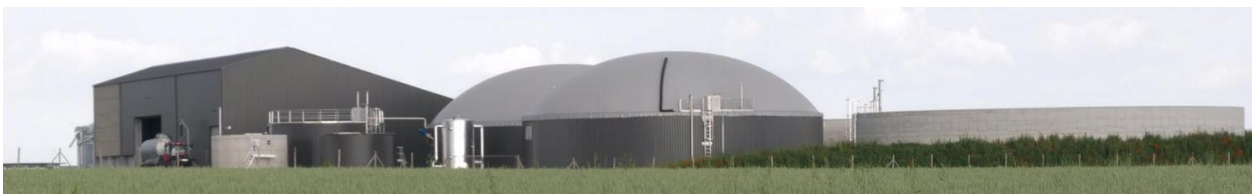
Figura 1.6 – Déméter: unidade de produção de biogás para fornecimento de calor e eletricidade, França
