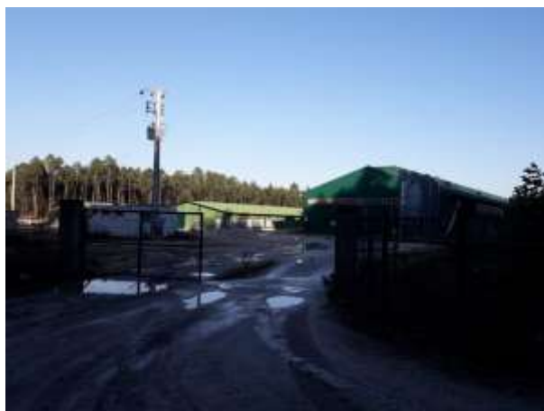
Figura 7.70 – Vista geral do terreno
