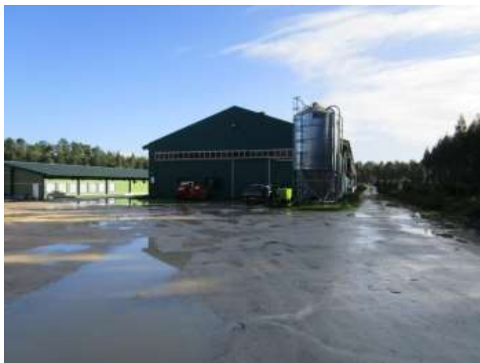
Figura 7.69 – Vista geral do terreno
