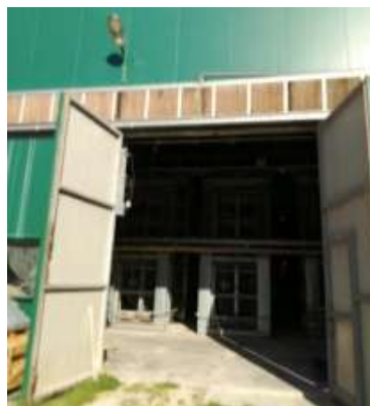
Figura 6.2 – Vista do interior do pavilhão de produção 1 (em vazio)
