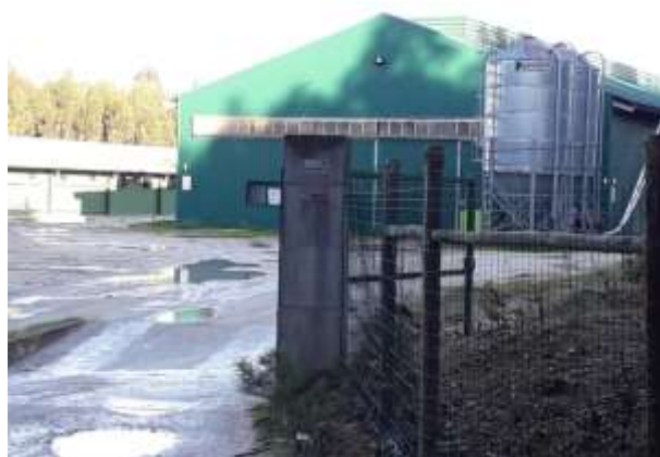
Figura 7.67 – Silo adjacente ao pavilhão de produção da Confrioovo, e vista sobre a área de eucaliptal.
