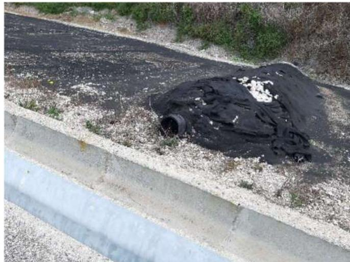
Figura 2 - Tubagem de escoamento de biogás.
