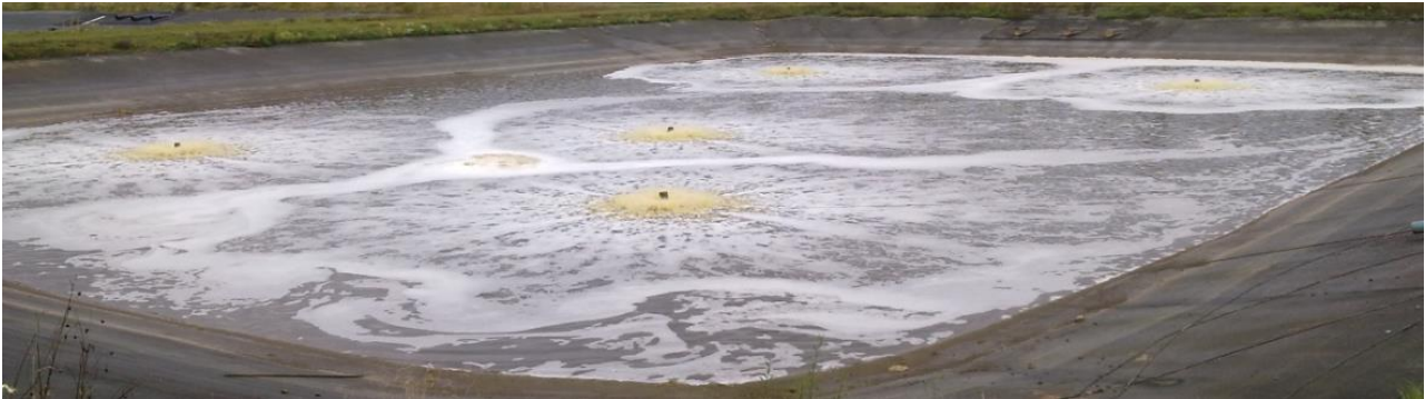
Figura 8 – Arejamento das lagoas
