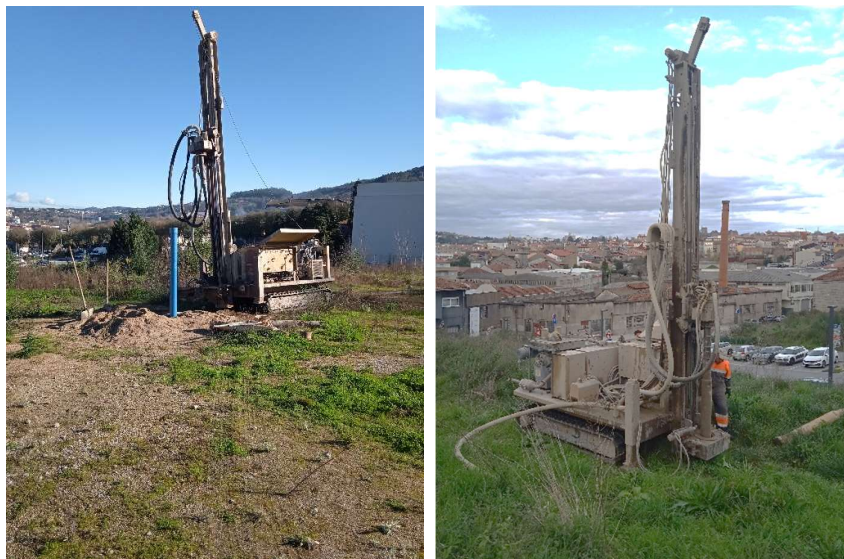
Figura 3 – Sonda Mobile Drill MX 100, com compressor Atlas Copco XRHS 396, utilizada para a abertura dos furos dos piezómetros.
