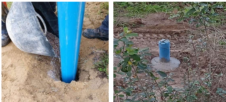
Figura 5 – Aspeto final da execução de um piezómetro.
