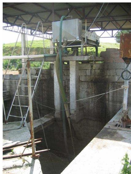
Fotografia 10 - Sistema de bombagem e separador de sólidos.
