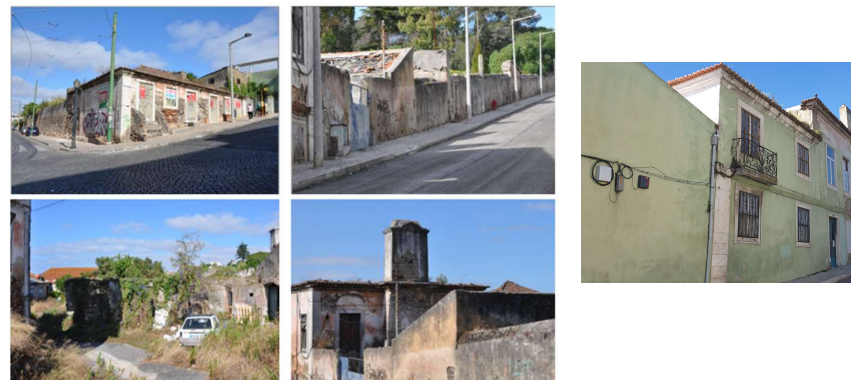
Edifícios a demolir
