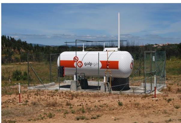
**Figura 7** – Depósito de gás propano utilizado para o aquecimento das instalações (Núcleo de Tojeiras I)
