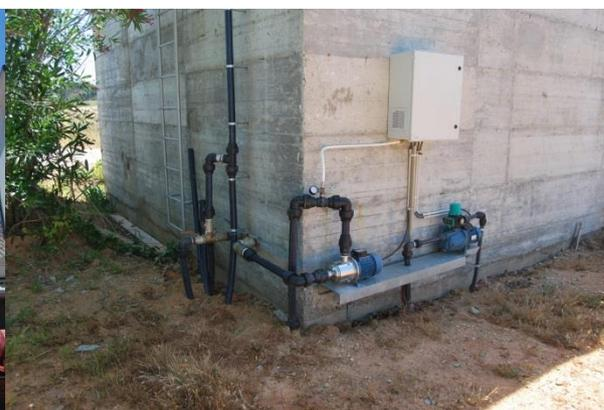
**Figura 6** – Depósito de água proveniente do furo (com contador), que abastece o pavilhão 1
