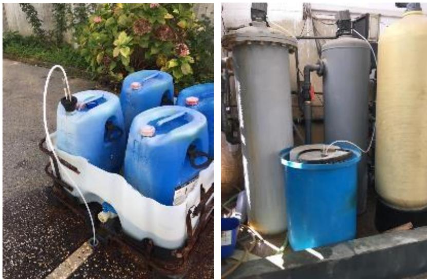
Figura 6. Desmineralizador para tratamento de águas de lavagem.
