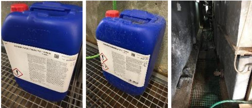
Figura 3. Armazenamento temporário de produtos químicos na linha de anodização (foto à direita representa a tina de retenção sob a linha de anodização).
