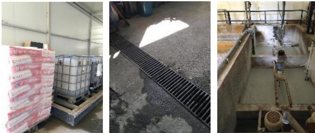
Figura 1. Armazenamento de produtos químicos na ETARI (a foto do meio representa a grelha existente na ETARI, cujos derrames são encaminhados para o tanque de recepção – foto à direita).
