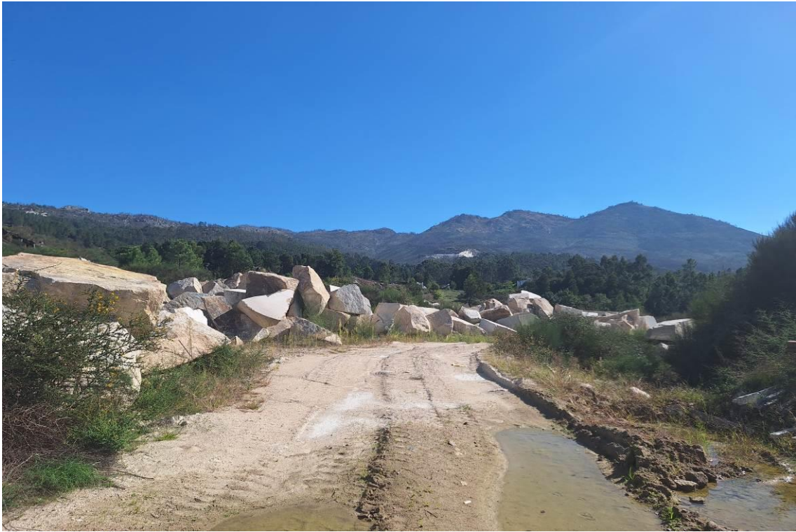
Foto 3 – Área B. Zona intervencionada. Acesso
