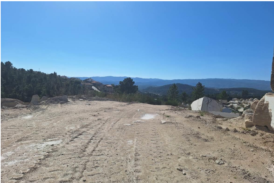
Foto 4 – Área B. Zona intervencionada. Outra vista
