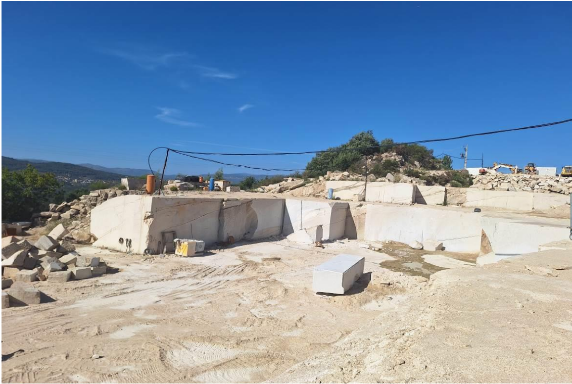
Foto 5 – Área B. Zona intervencionada, frente de extração
