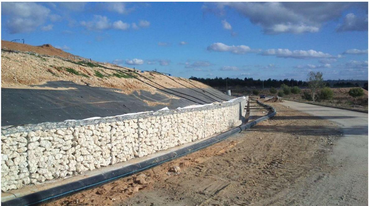
**Foto 18 – Construção de muro de gabião**
