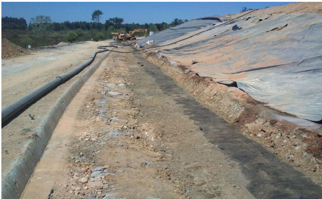
**Foto 13 – Demolição da valeta periférica, remoção de terras e resíduos e colocação de sistema de impermeabilização de fundo à vista**
