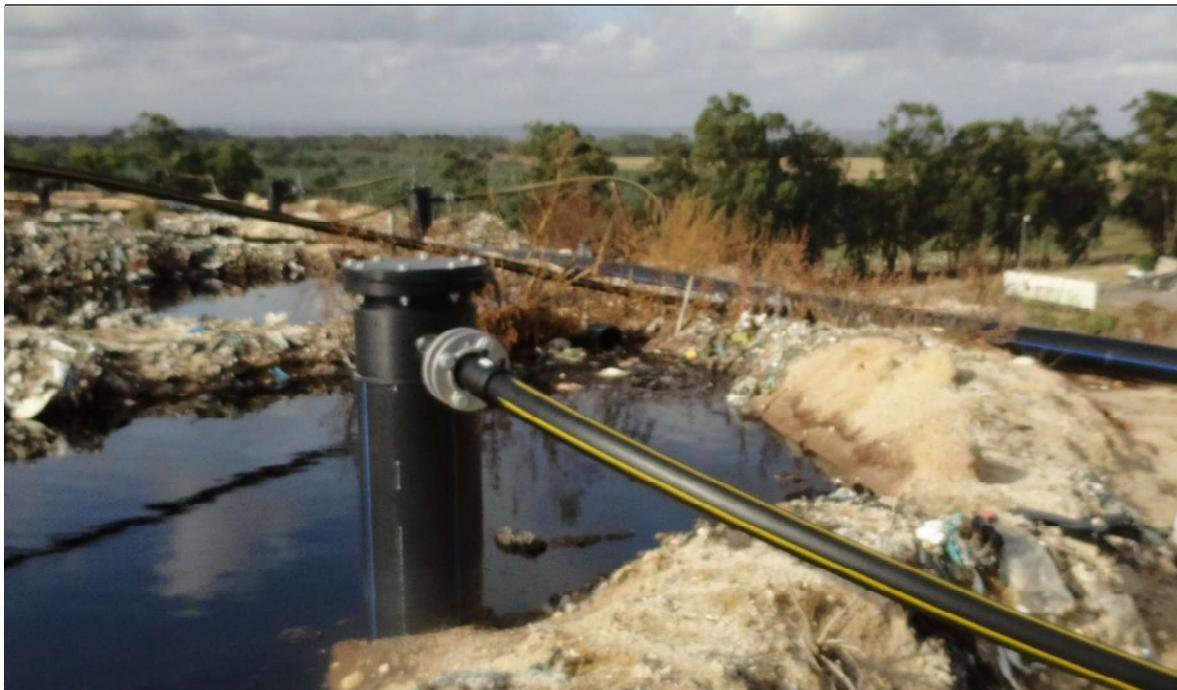
**Foto 9 – Poço de captação de biogás sem sistema de extração de lixiviados**
