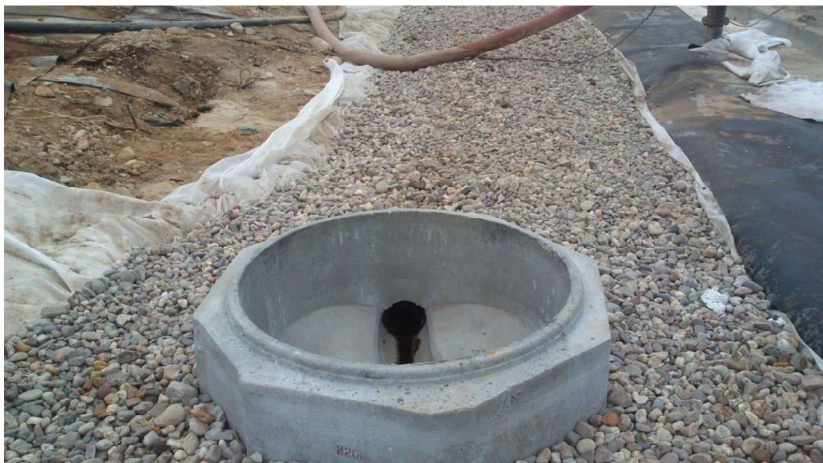
**Foto 12 – Dreno periférico, em banquetas e acessos e caixa de reunião para encaminhamento para a rede exterior**
