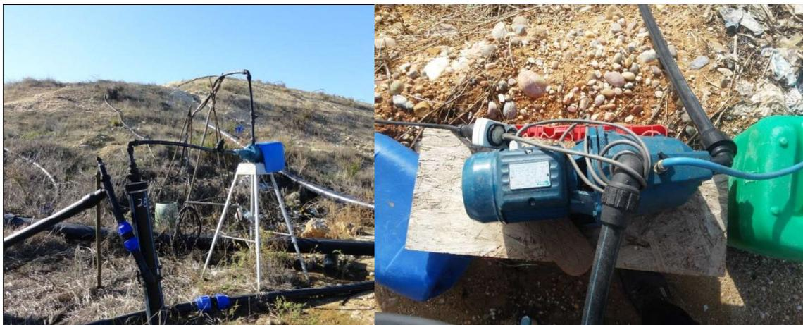
**Foto 6 – Sistemas de bombagem de lixiviados de poços verticais existentes**
