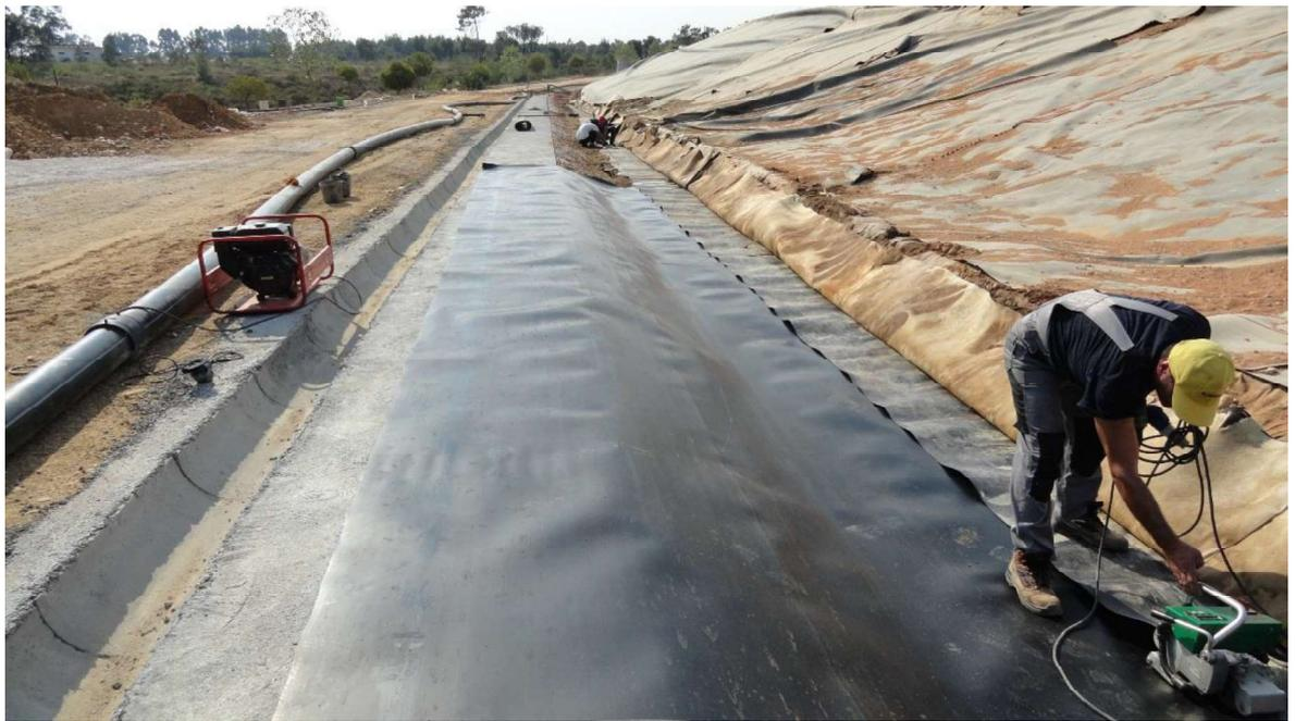
**Foto 15 – Prolongamento do sistema de impermeabilização de fundo**
