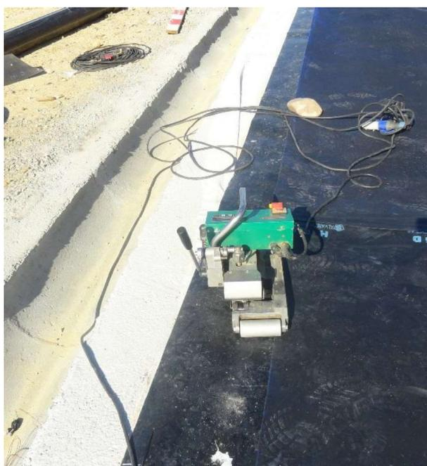
**Foto 17 – Soldadura entre o sistema de impermeabilização de fundo e da cobertura**
