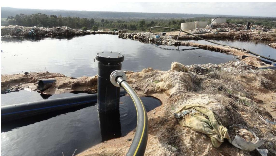
**Foto 4 - Exemplo de poço de extração vertical**
