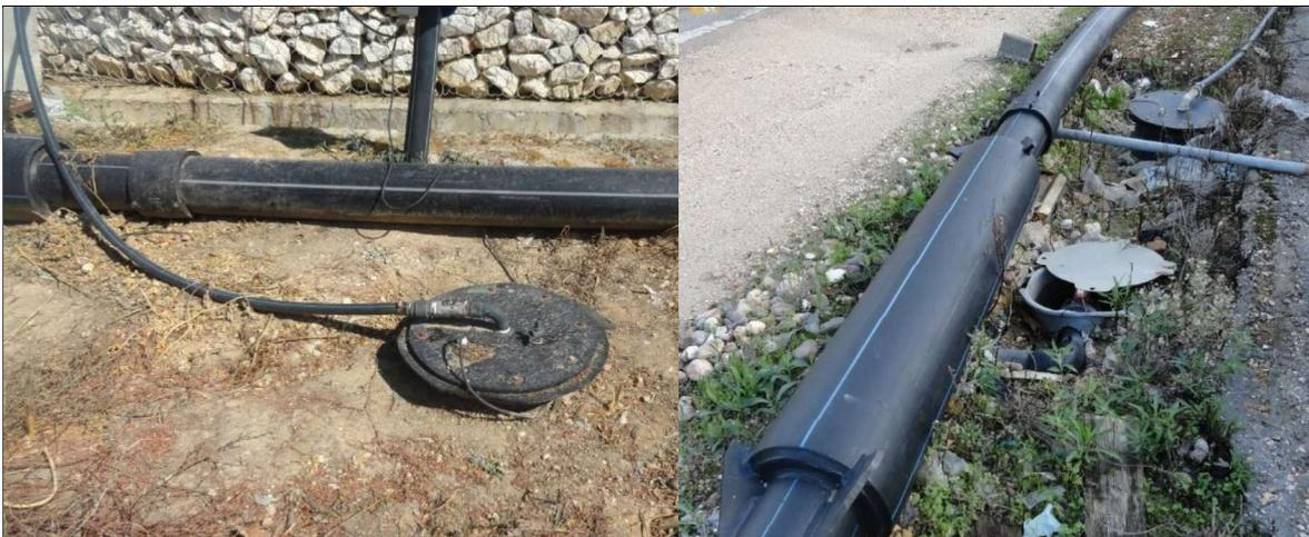
**Foto 10 – Poços de condensados**
