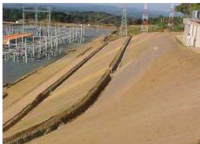
**Foto 20 – Biomantas – estabilização dos taludes**
