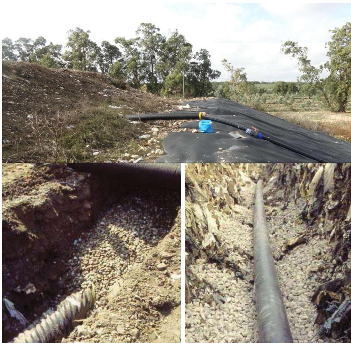
**Foto 5 – Dreno horizontal de extração de biogás**
