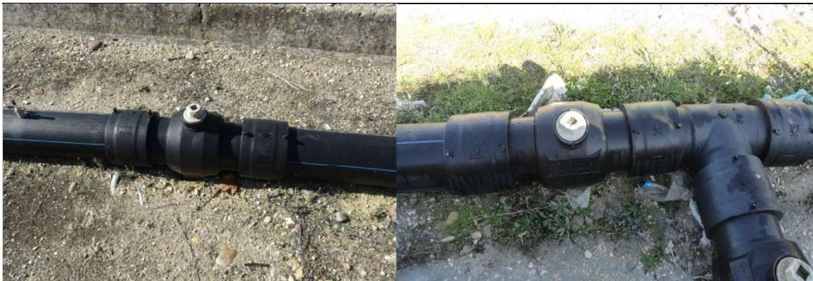
**Foto 1 – Válvulas de secionamento do coletor periférico de biogás**
