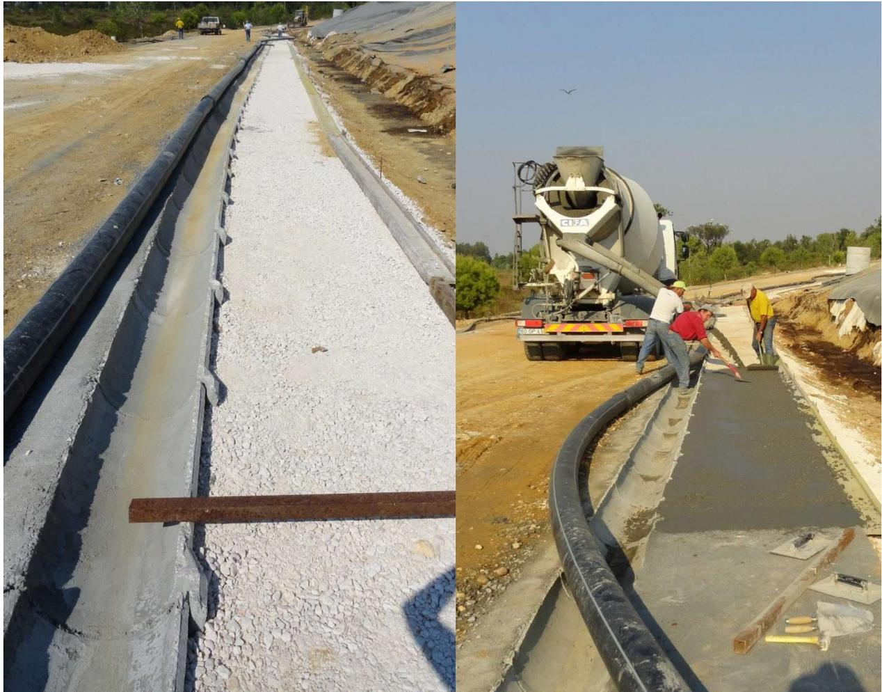
**Foto 14 – Construção da base de assentamento do gabião**
