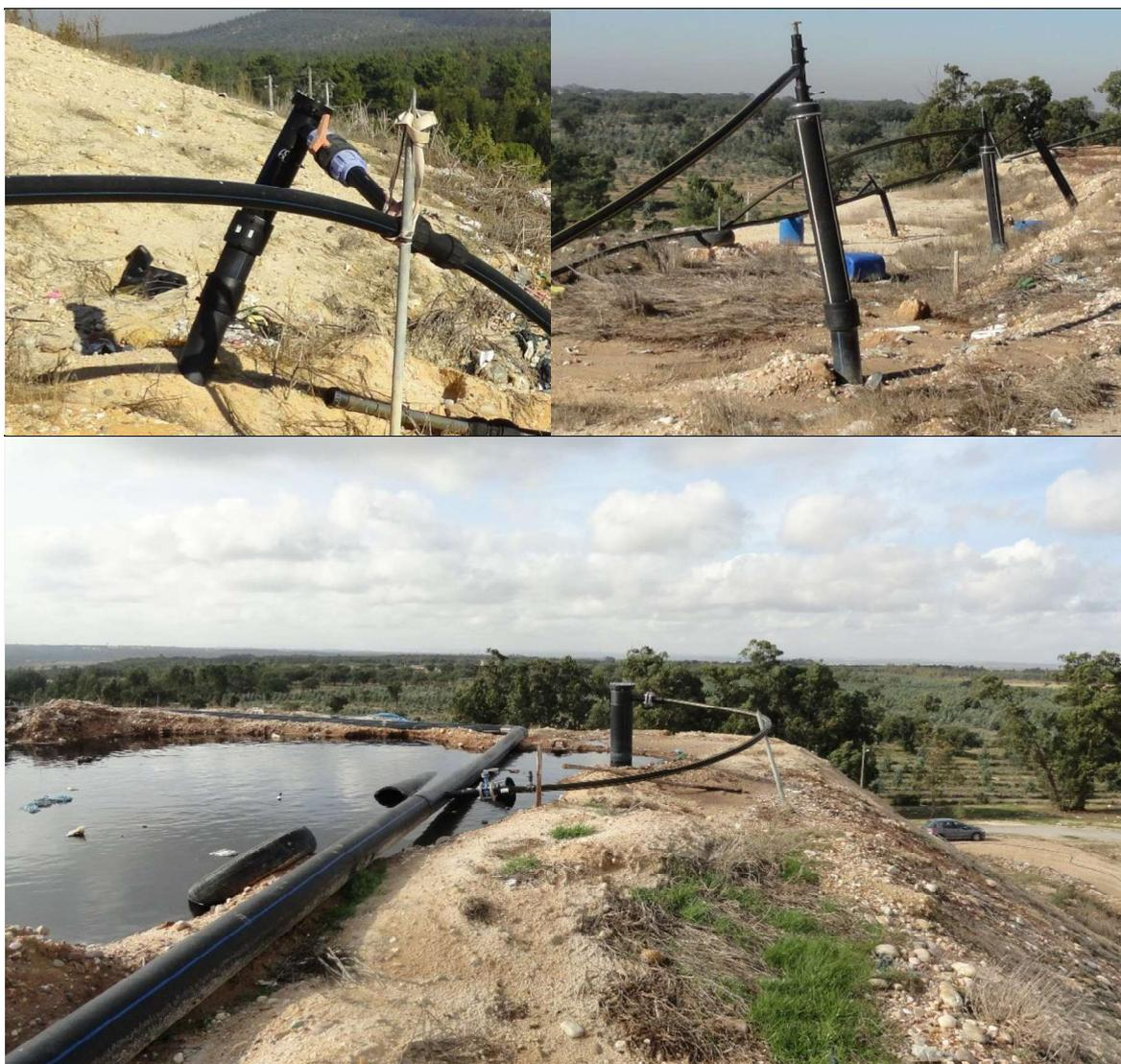
**Foto 3 – Exemplos de poços de biogás do aterro sanitário de Ecoleziria**
