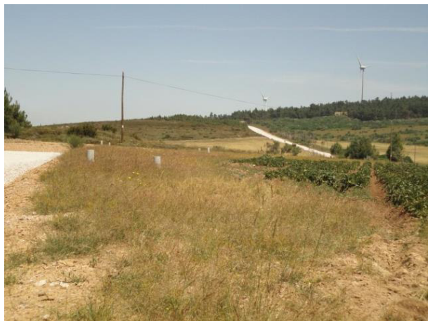
Regeneração natural da vegetação na zona adjacente ao caminho (faixa ao longo do trajeto da vala de cabos)
