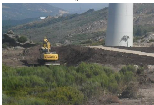
Trabalhos de regularização de taludes e recuperação ambiental junto a um aerogerador
