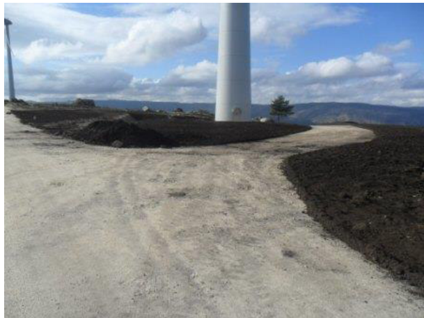
Exemplo da recuperação ambiental dos taludes junto a um aerogerador e ao longo do caminho de acesso (cobertura com terra vegetal)
