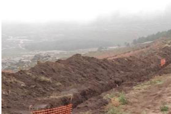
Exemplo de separação e armazenamento de terra ao longo de uma vala
