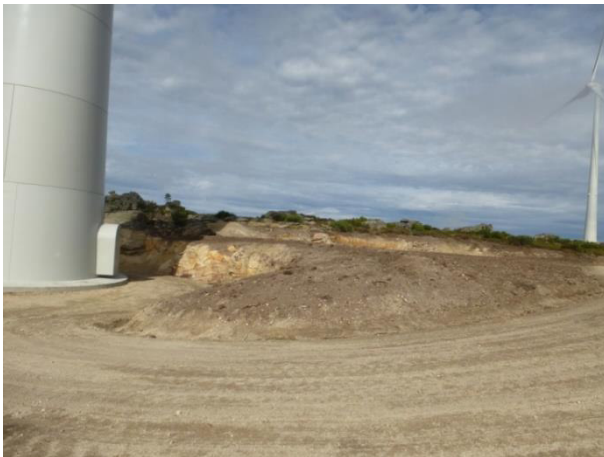
Exemplo da recuperação ambiental dos taludes junto a um aerogerador (modelação de taludes)
