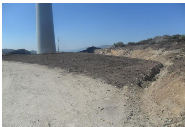
Recuperação ambiental com modelação de taludes e recuperação da plataforma
