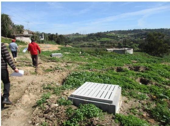
Fotografia 13 - Caixas de visita pertencentes ao sistema de condução do efluente pecuário ao sistema de tratamento.
