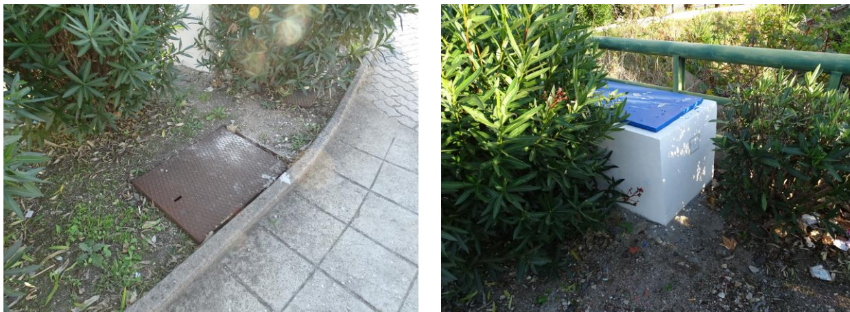
Figura 1 – Vista de caixas de serviços junto ao passeio Sul.
