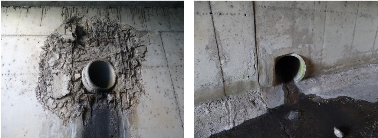
Figura 3 – Conduitas de águas residuais que atravessam o montante Oeste.
