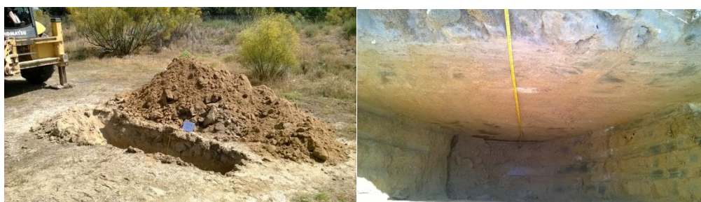
Figura 10. Aspeto de uma vala de inspeção.
