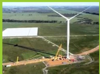
Exemplo de montagem da aerogerador
