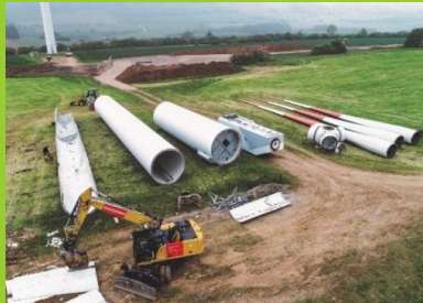
Desmantelamento de aerogeradores
