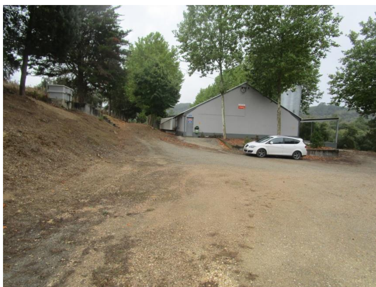
Figura 7.61 – Vista geral do terreno na área de implantação do pavilhão II (solo urbano)
