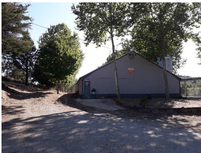
Figura 6.5 – Vista do exterior do Pavilhão de VGII
