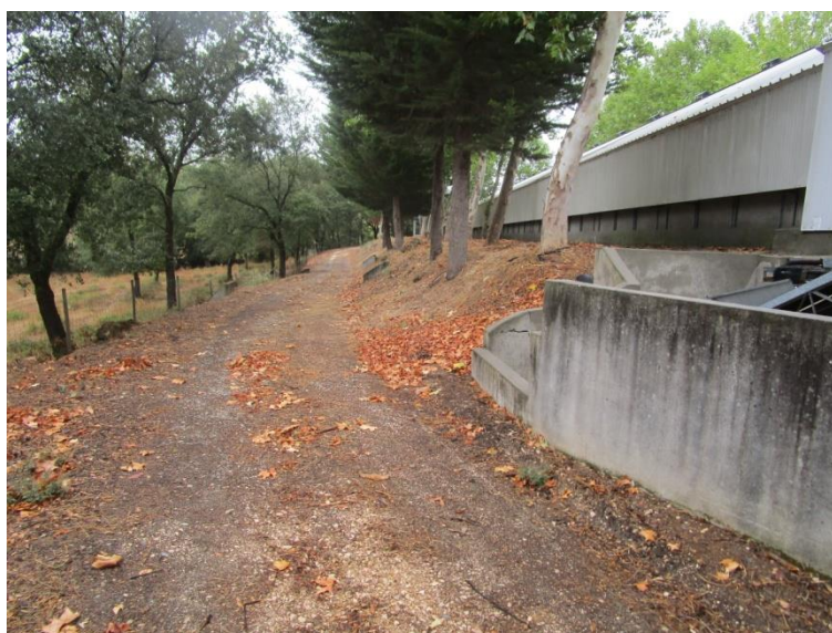
Figura 7.62 – Vista geral do terreno na área de implantação do pavilhão II (solo urbano)
