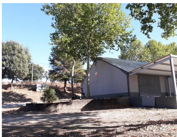
Figura 6.3 – Vista do exterior do pavilhão VGII
