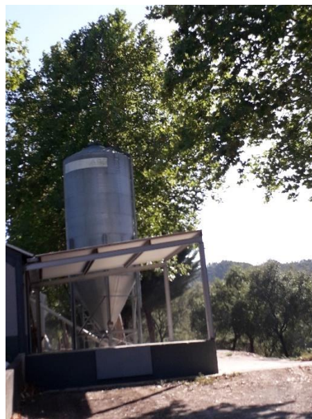
Figura 6.7 – Silos de ração junto ao pavilhão de produção – VGII
