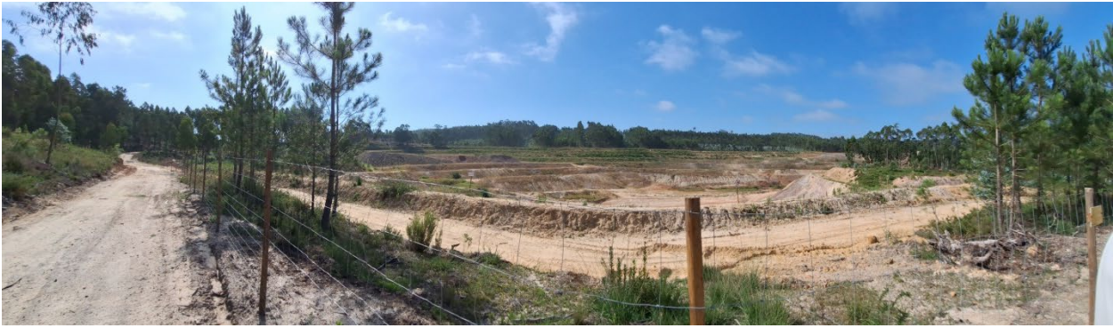
Vista geral da pedreira
