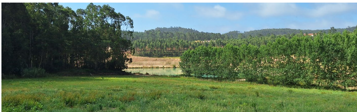
Envolvente da pedreira (ao fundo, pedreira – bancadas em modelação e lagoa)
