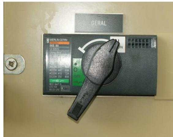
1. Após **ALARME**, desligue imediatamente o botão de corte elétrico geral (indicado na figura), sempre com as mãos secas
