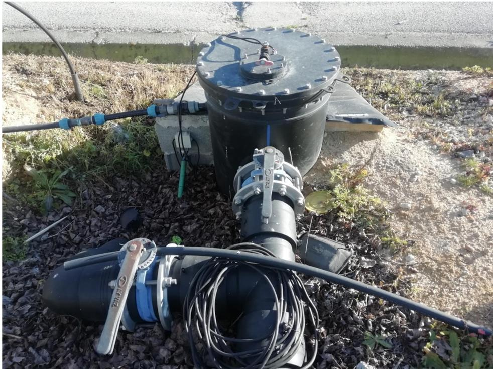
Poço de condensados
