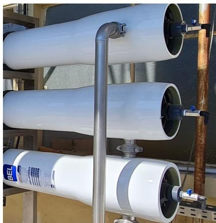
Figura 59 - Representação gráfica e fotográfica dos invólucros das membranas da unidade de osmose inversa
