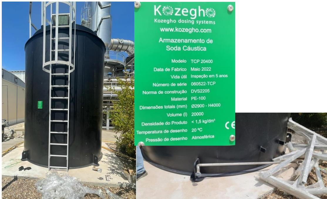
Figura 47 – Registo fotográfico do depósito de dupla parede de armazenagem solução alcalina
