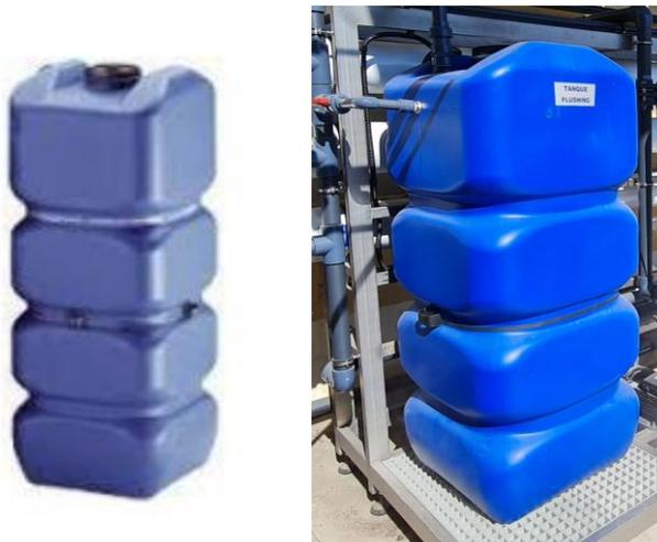
Figura 61- Representação gráfica e fotográfica do modelo de depósito vertical do circuito Flushing
