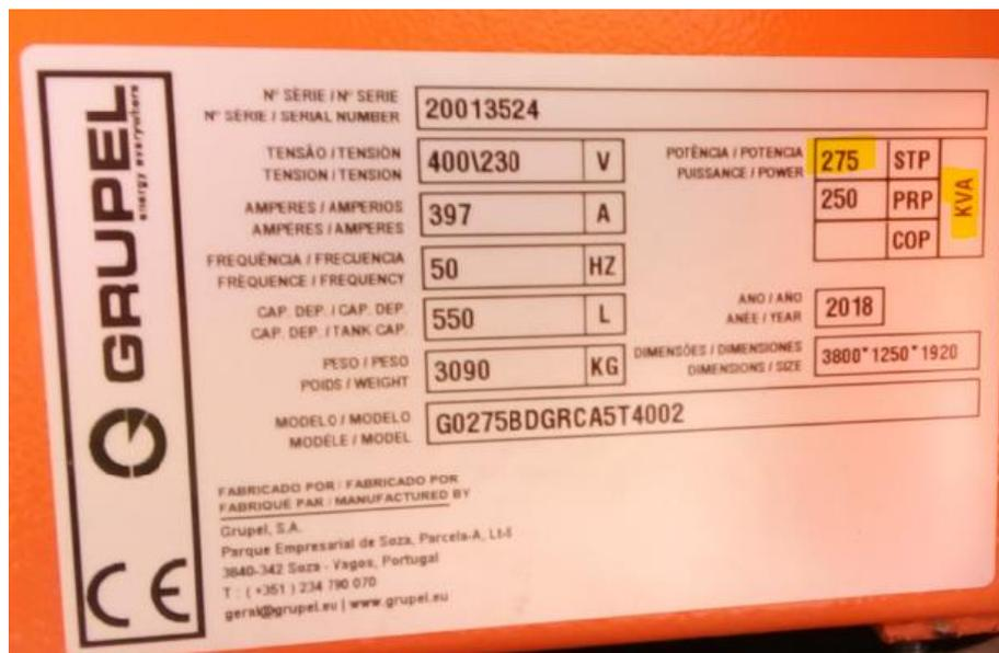
Figura 2- Potencia térmica do gerador de emergência (275 KVA x 0,96 = 264 KW = 0,264 MW)
