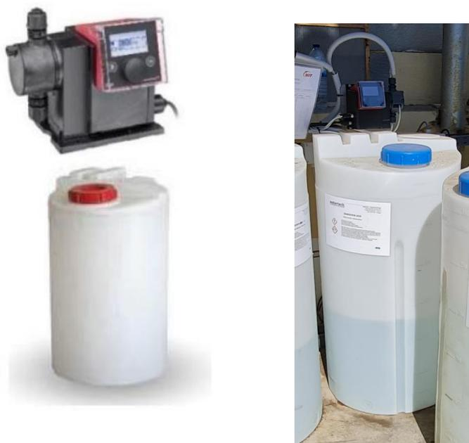
Figura 55 - Representação gráfica e fotográfica do sistema de dosagem de redutor de cloro
