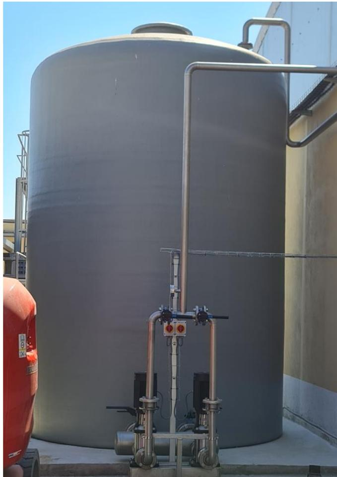
Figura 65 – Registo fotográfico de depósito de armazenagem de água tratada por osmose inversa
