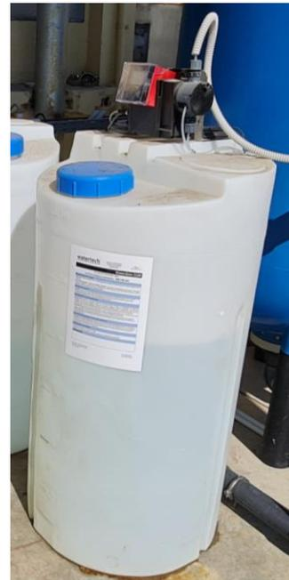
Figura 54- Representação gráfica e fotográfica do sistema de dosagem de desinfetante
