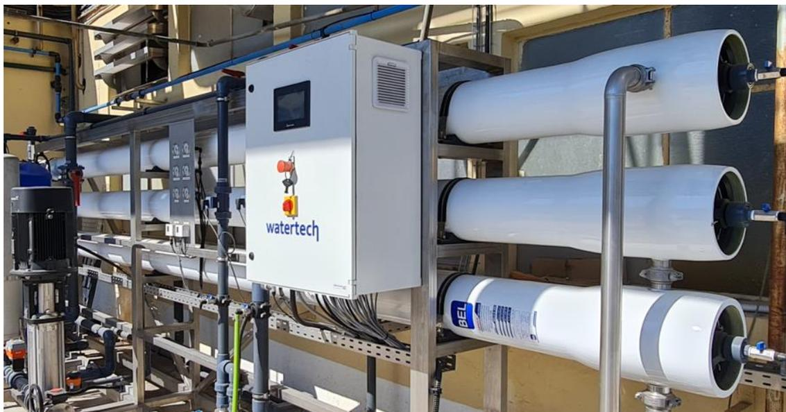
Figura 58- Registro fotográfico de uma unidade de osmose inversa
