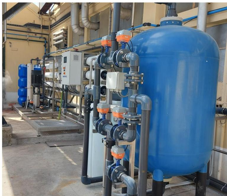
Figura 52 – Registo fotográfico do sistema a instalar de tratamento de água por osmose inversa
