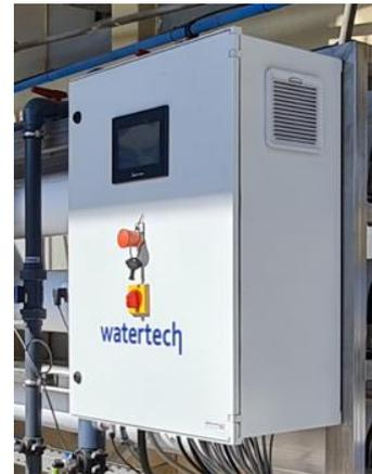
Figura 63- Representação gráfica e fotográfica do quadro elétrico com a sua consola táctil.
