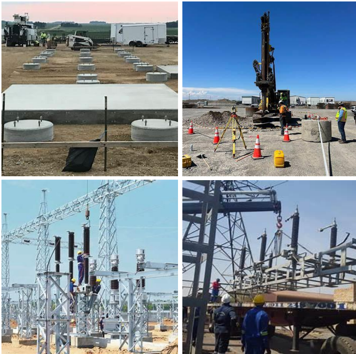
Figura 6 – Montagem de subestação
