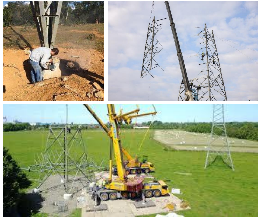
Figura 7 – Montagem dos apoios das linhas elétricas
