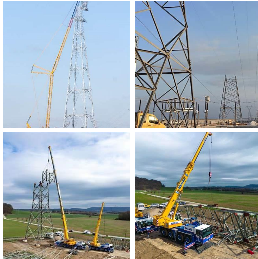
Figura 8 – Desmantelamento dos apoios de linha
