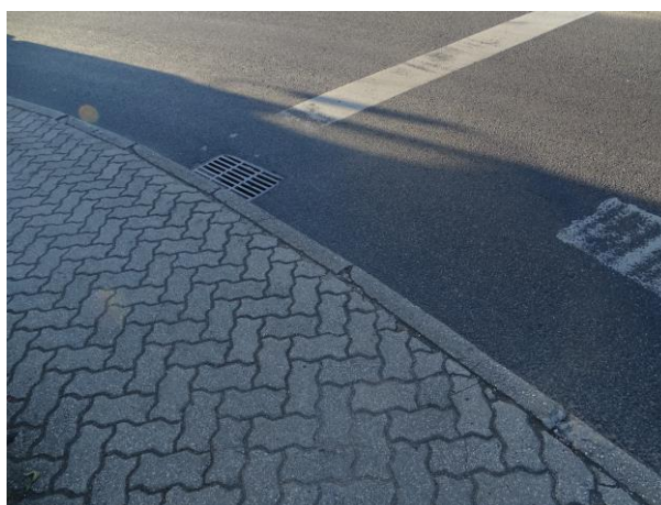
Figura 2 – Vista de um dos sumidouros na zona da obra de arte.
