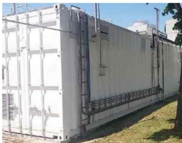
Este Gerador Eletrolítico foi adquirido como uma solução “chave na mão” e encontra-se montado dentro de um contentor marítimo, com as necessárias adaptações, pelo que o seu transporte é facilitado não dando lugar a quaisquer obras de construção civil, que não sejam as de eventual necessidade de reforço de estabilidade do piso.
