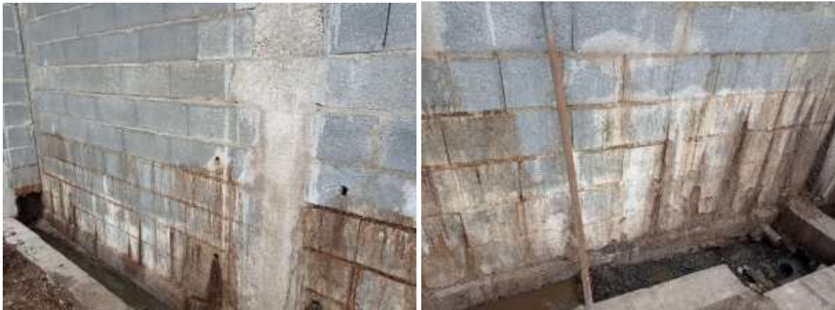
Figura 4 - Calha de recolha e escorrências da nitreira
