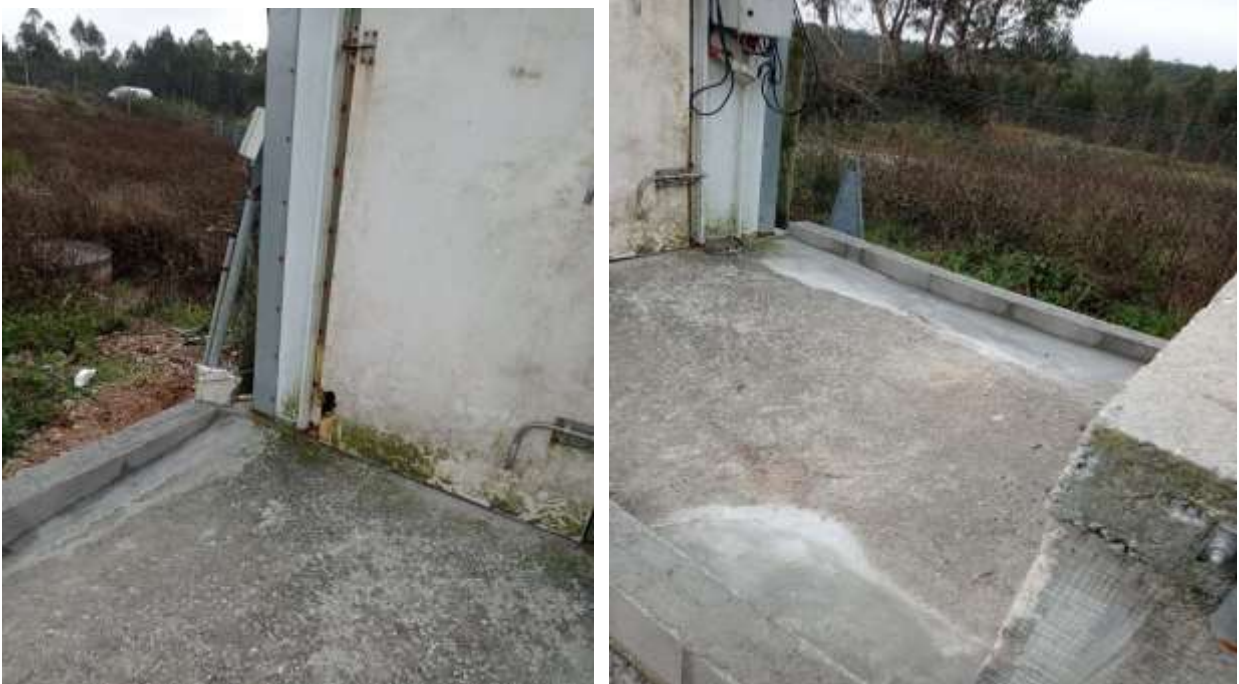
Figura 3 - Colocação de lancil para encaminhar as escorrências do necrotério para a caixa de recolha
