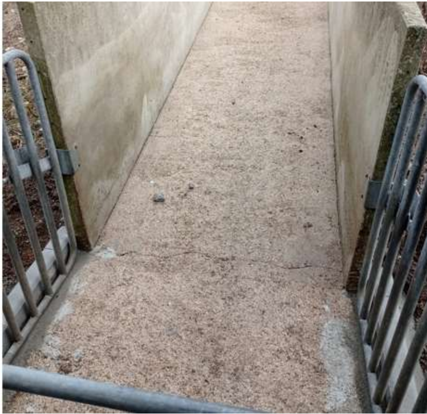
Figura 2 - Colocação de lancil para evitar escorrências
