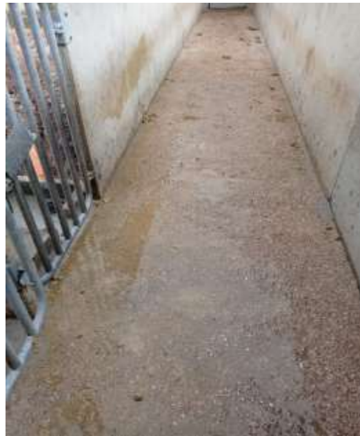
Figura 1 - Encaminhamento das águas de lavagem para o sistema de retenção
